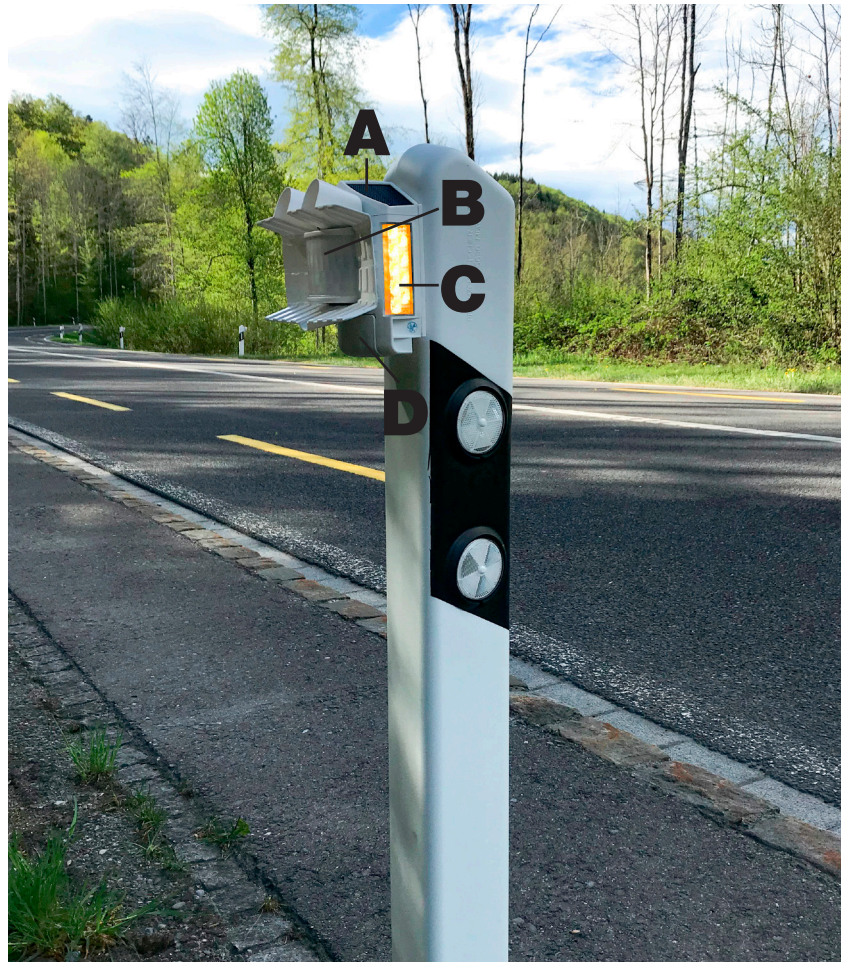
Die Module der Wildwarnanlage werden an die weissen Strassenleitpfosten mit einem maximalen Abstand von 50 Metern montiert. Die Hauptbestandteile eines Moduls sind: A) Solarmodul, B) Erkennungssensor, C) LED-Warnsignal und D) Akkufach und Speicherung der Daten. Quelle: Forschungsgruppe Wildtiermanagement, ZHAW
