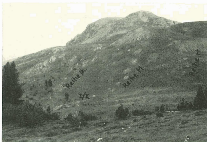
Abb. 5. Der Abhang über Fop da Buffalora. Drei Reihen von Schürfstolien sind erkennbar. In der mittleren Reihe liegen die begehbaren Stolien «Scheraweg I» und «II». Über der Bildmitte in Fortsetzung der Reihe links die Halde einer produktiven Grube.
