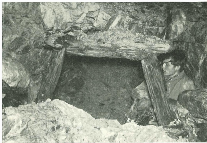
Abb. 13. Ein noch vollständiges Zimmerungselement im Marangunstollen , das dem Gebirgsdruck durch vier Jahrhunderte standgehalten hat.
