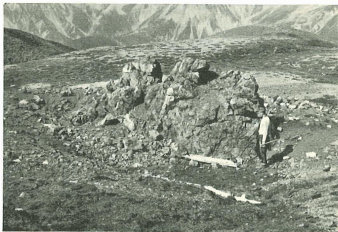
Abb. 17. Plateau Munt Buffalora. Der «Rote Stein» wurde offenbar im Tagbau mittels Feuerstein abgebaut. Die Klüfte dieses Wettersteindolomitklotzes sind mit Eisenerz imprägniert.
