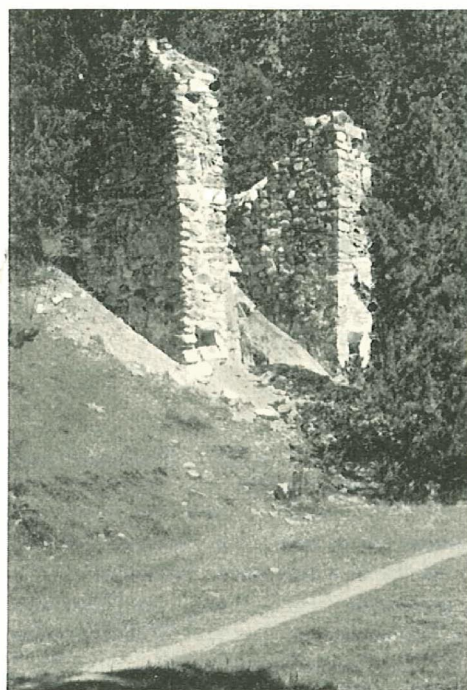
Abb. 41. Der Ofen Il Fuorn II , ein lombardischer Flossofen von 1684/85, errichtet auf den Grundmauern eines ebensolchen aus dem 16. Jahrhundert (Il Fuorn I).
